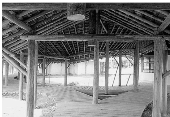
Figura 3: Passarela coberta de ligação entre os espaços dos laboratórios do Centro de Proteção Ambiental de Balbina. Foto: Acervo pessoal do arquiteto Severiano Porto.
